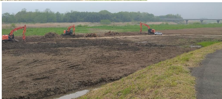
有害鳥獣河川敷緩衝帯整備事業（小山市思川）
