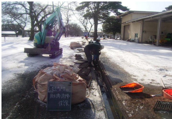
側溝内の堆積物の除去
