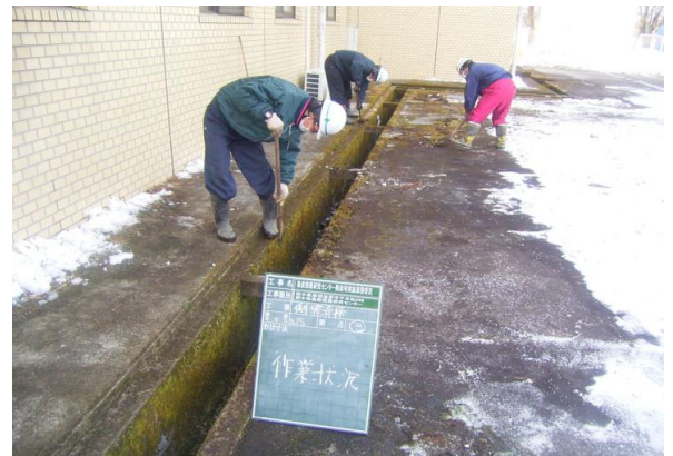
側溝等の苔の除去
