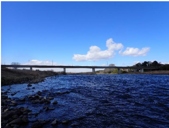
地点7 八溝大橋 下流
